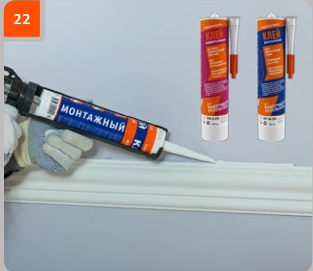
Füllen Sie die Fuge zwischen Produkt und Wand mit Klebstoff an den Stellen, an denen kein Klebstoff ausgetreten ist.
