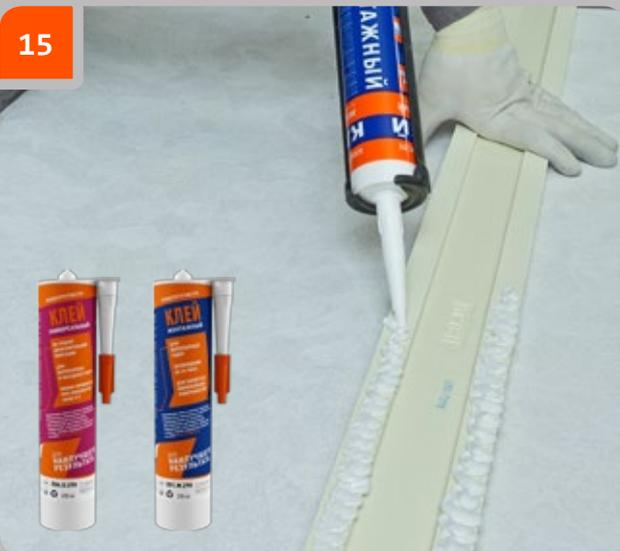
«Evroplast Mounting» oder «Evroplast Multipurpose» Kleber auf die Montagefläche des nächsten Produkts auftragen.
