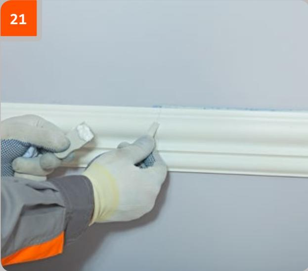
Die geschliffenen Fugen mit feinkörniger, wasserlöslicher Spachtelmasse für den Innenausbau füllen, ggf. «Schritt 20» wiederholen, bis eine ebene Fläche entsteht.
