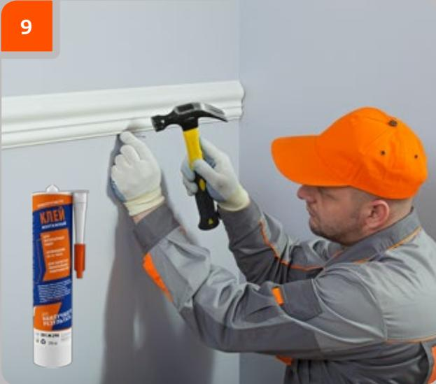
Bei Verwendung des Klebers «Evroplast Mounting» ist es notwendig, ihn mit unter dem Produkt eingeschlagenen Senkkopfnägeln zu fixieren, um ein Verrutschen des Produkts zu verhindern. Die Nägel werden nach 24 Stunden entfernt.
