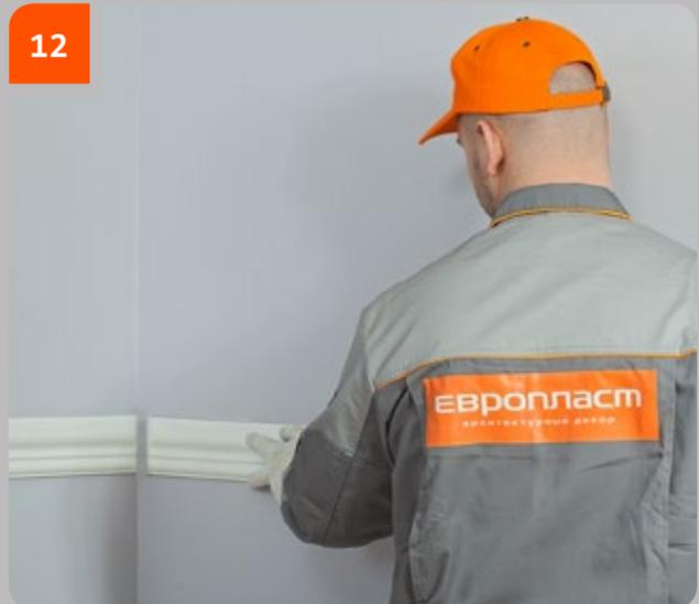
Schneiden Sie das nächste Produkt. Überprüfen Sie die Verbindung des Musters und des Profils der Produkte, ggf. wiederholen Sie den Schnitt.
