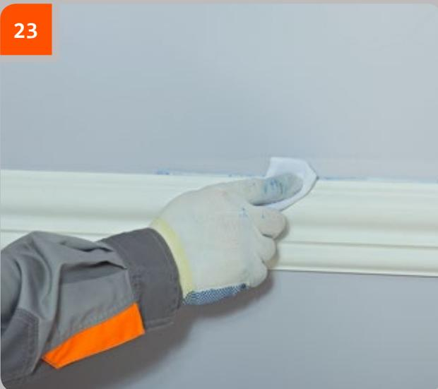
Wischen Sie den überschüssigen Kleber mit einem mit Wasser benetzten Tuch ab, wenn Sie den Kleber «Evroplast Mounting» verwenden; mit Aceton, wenn Sie den Kleber «Evroplast Multipurpose» verwenden.
