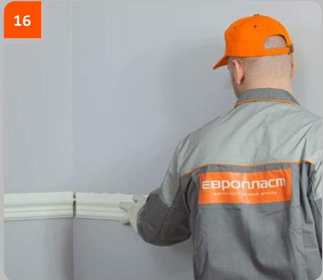
Drücken Sie das Produkt an die Wand, so dass Klebstoff unter der gesamten Verbindungsfläche austritt. Bewegen Sie das Produkt entlang der Wand und schieben Sie es zum angrenzenden Produkt, so dass Klebstoff aus der Fuge austritt.
