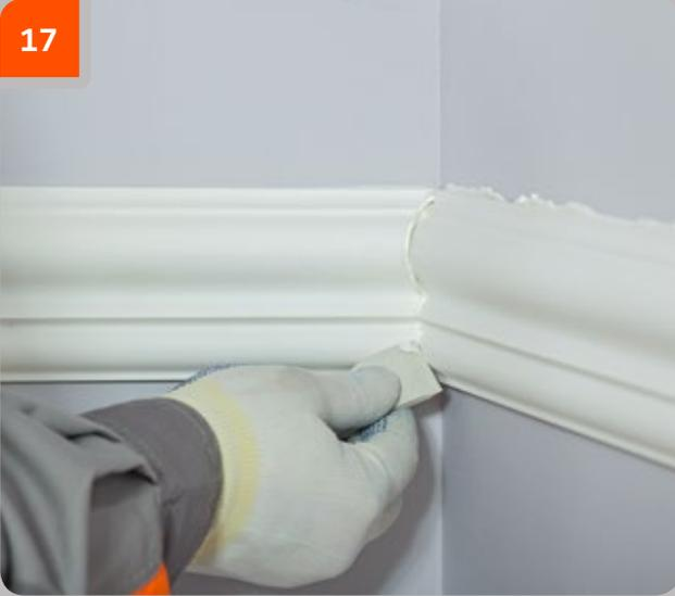
Überschüssigen Klebstoff unmittelbar nach dem Anbringen mit einem Spachtel entfernen.
