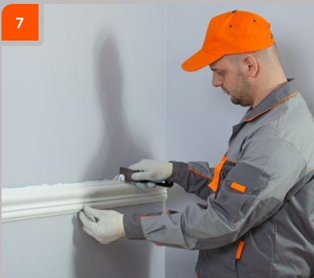
Unmittelbar nach dem Anbringen, überschüssigen Klebstoff mit einem Spachtel entfernen.
