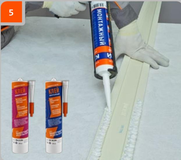
«Evroplast Mounting» Kleber auf die Montagefläche oder «Evroplast Multipurpose» Kleber über die gesamte Produktlänge auftragen. Die Dicke der aufgetragenen Klebstoffschicht muss 3-5 mm betragen.
