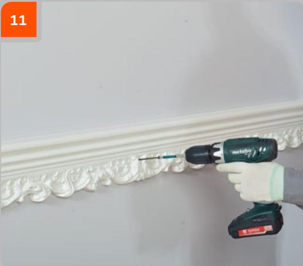
Bei Produkten über 100 mm Höhe ist eine zusätzliche Befestigung mit Schneidschrauben im Abstand von ca. 600 mm erforderlich.
