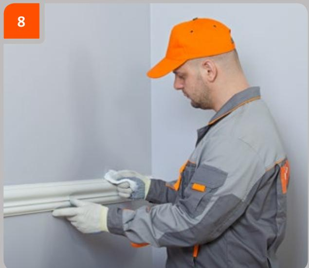
Falls erforderlich, wischen Sie die Verbindungsstelle zwischen Produkt und Wand mit einem mit Wasser benetzten Tuch ab, wenn Sie den Kleber «Evroplast Mounting» verwenden; mit Aceton, wenn Sie den Kleber «Evroplast Multipurpose» verwenden.
