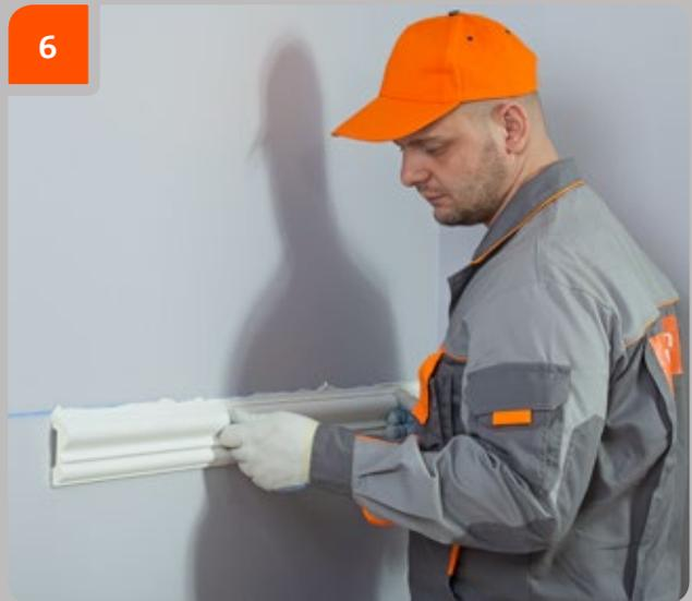
Befestigen Sie das Produkt an der Montagestelle gemäß der Markierung an der Wand. Drücken Sie das Produkt über die gesamte Länge an, so dass Klebstoff unter der gesamten Verbindungsfläche austritt.
