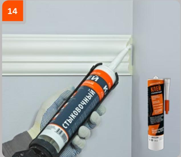
Evroplast für Klebeverbindungen Kleber auf die Endfläche des bereits montierten Produkts auftragen.
